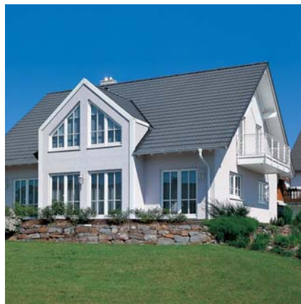
Bild 85: Einfamilienwohnhaus in Niedrigenergiebauweise
