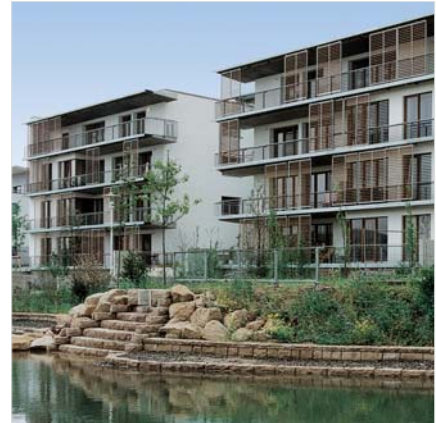
Bild 3: Mehrfamilienwohnhäuser – Kronsberg-Siedlung, Expo Hannover
