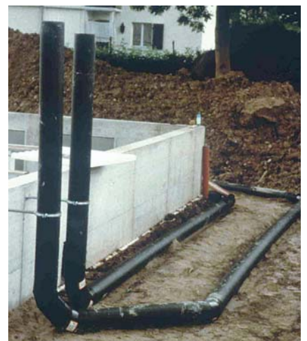
Bild 65: Erdwärmetauscher-Verlegung im erweiterten Arbeitsraum des Gebäudes (Quelle: Passivhäuser Wegere (CH), CEPHEUS Endbericht 2001)
