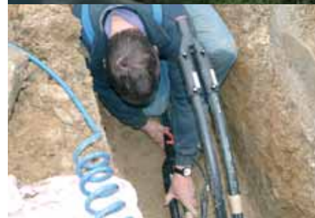
Unten: Verschweißen der Zuleitungen
