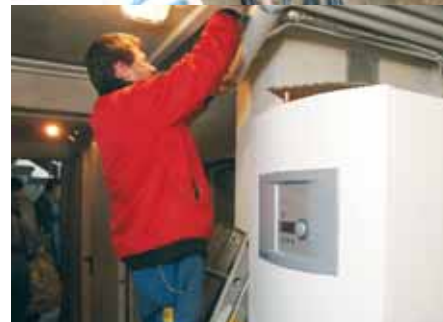
Anschluss und Inbetriebnahme des Erdwärmepumpensystems
