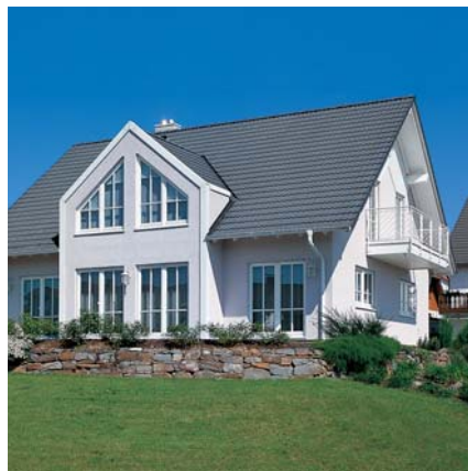
Bild 85: Einfamilienwohnhaus in Niedrigenergiebauweise
